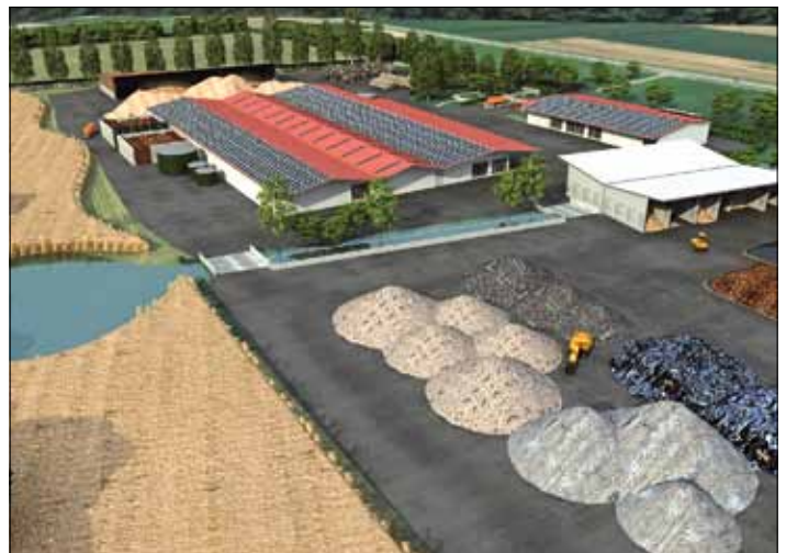
Zukunftsprojekt Biomassezentrum mit Energiepark
